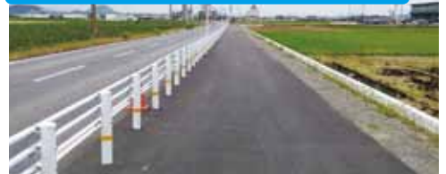
大房町～小船木交差点の整備がこのほど完成しました。
