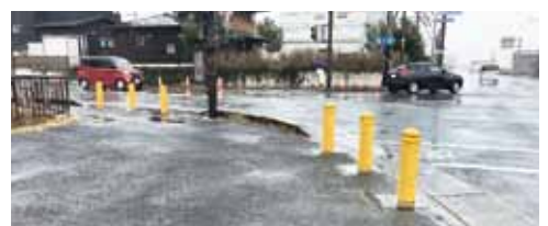
通学路や保育園児のお散歩コースの事故防止対策として、グリーンベルト、防護柵やボラードと呼ばれる車の突っ込みを防ぐ対策など様々な対策を推進しています。
